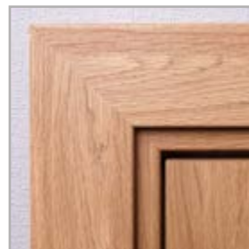
standardní spojování lišt pod úhlem 45°
