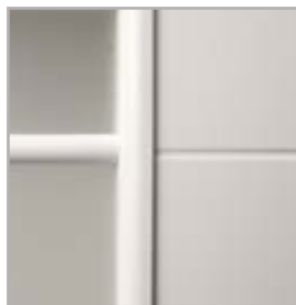
pohled na frézování
