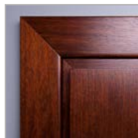
spojování lišt pod úhlem 45°
